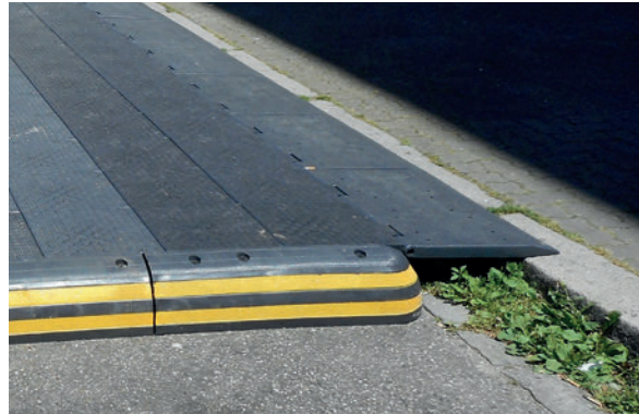
Grilles mobiles ZICLA de mise à niveau avec le trottoir (Source : Brigitte Baur/Strasbourg Eurométropole)
