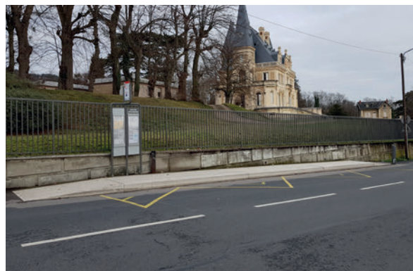
Point d'arrêt de bus avec des modules de quai préfabriqués en béton (Source : Aménagement Lyonnais)
