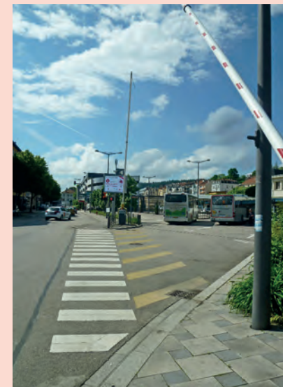
Épinal : une gare routière ouverte (photo : Cerema Est)
