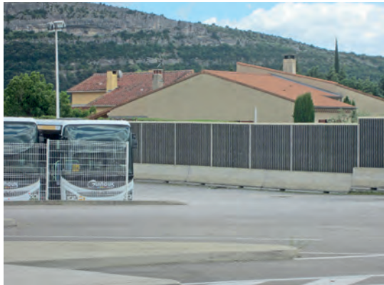
Gare routière d'Aubenas: un mur anti-bruit protège les habitations voisines (photo: Cerema Centre-Est)
