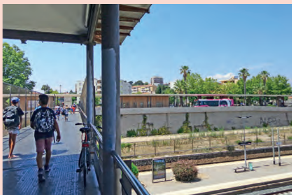
Au-dessus des voies ferrées, une corniche longe le bâtiment de la gare routière (photo : Cerema Méditerranée)
