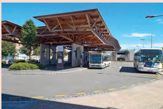
Le bâtiment de la gare routière : une volonté architecturale forte (photo : Cerema Nord - Picardie)
