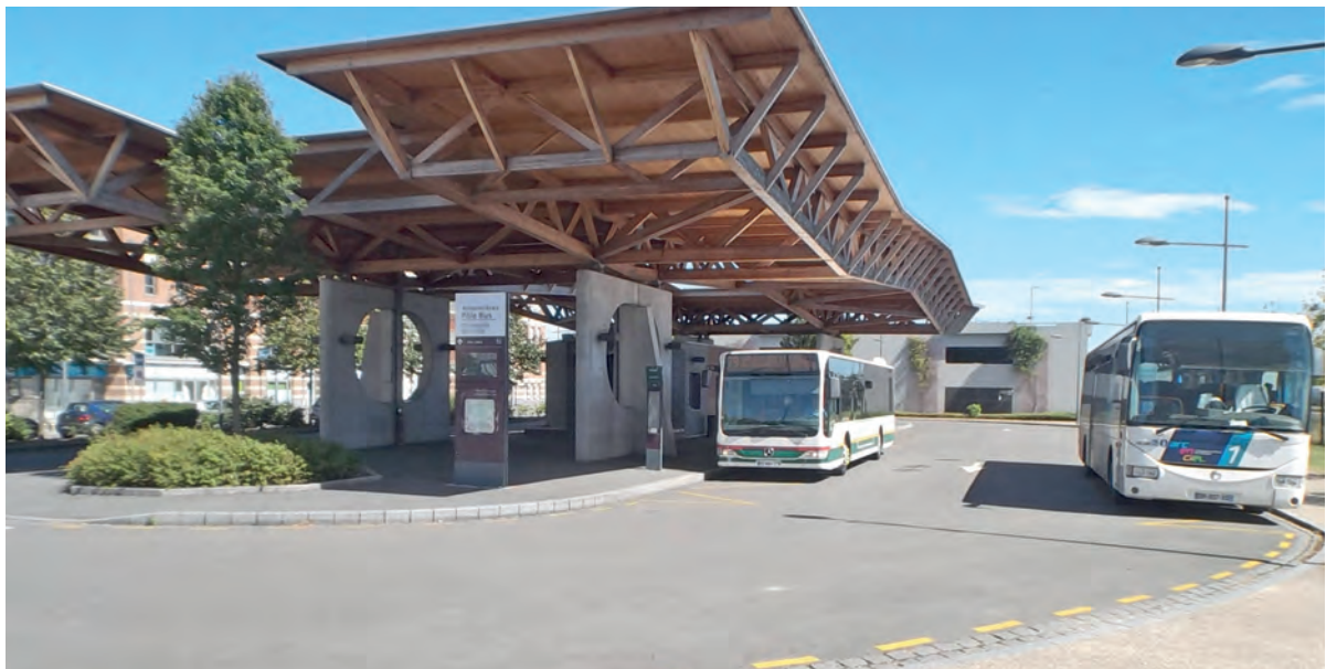
Exemple de quai central à Armentières (photo : Cerema)
