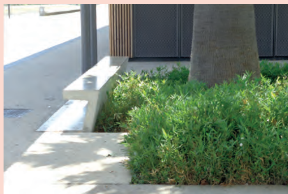
Les bambous nains sont garants de la gestion des eaux pluviales et évitent que les usagers ne traversent les espaces plantés (photo : Cerema Méditerranée)
