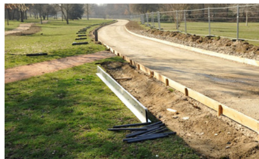
Mise en œuvre des sous-couches de roulement
